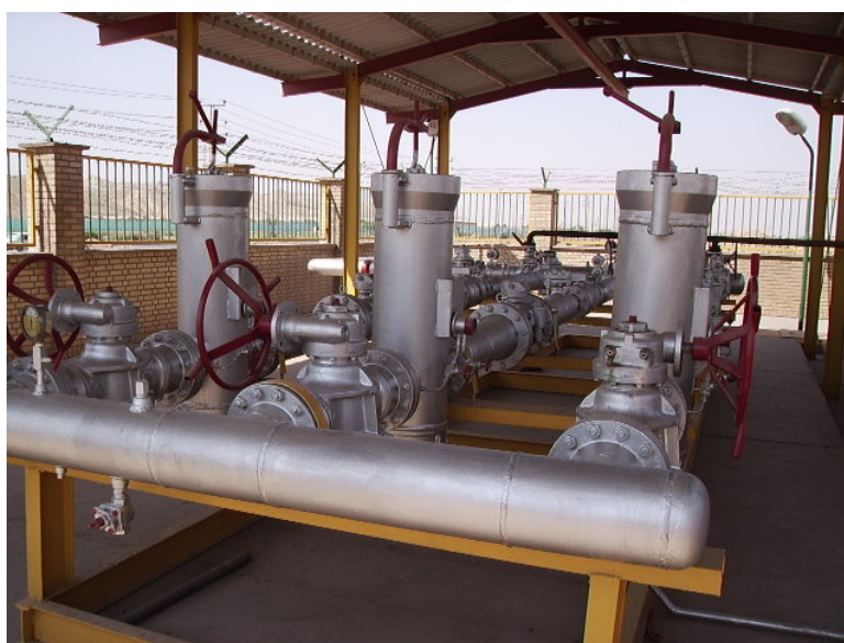
شکل ۳-۱۵: نمونه‌ای از ایستگاه TBS مسطح
