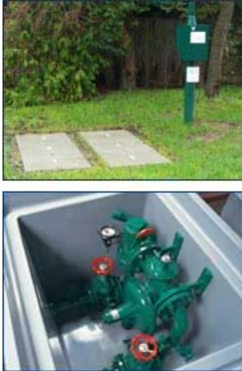
شکل ۳-۳۹: شماتیکی از یک ایستگاه زیرزمینی شرکت Elster
