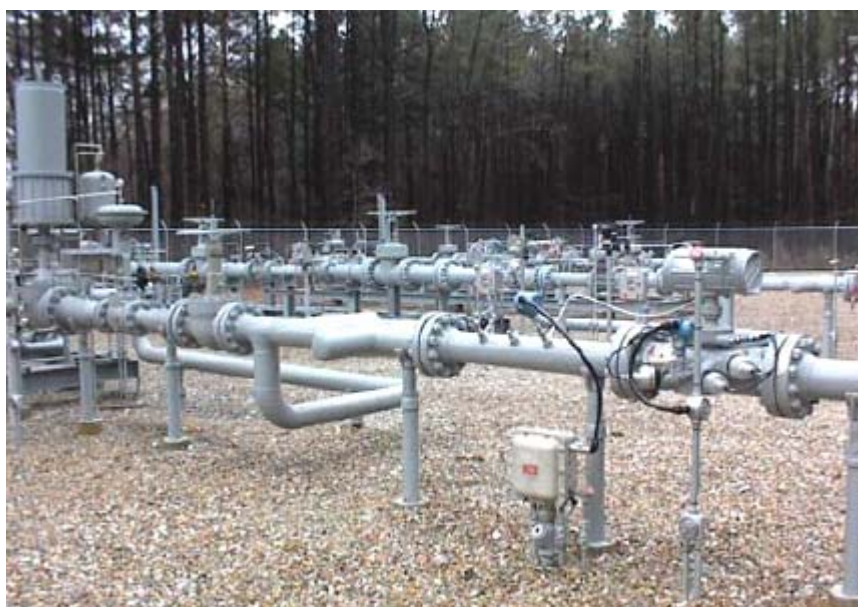
شکل ۳-۵۷: نمونه‌ای از یک سایت اندازه‌گیر کوچک
