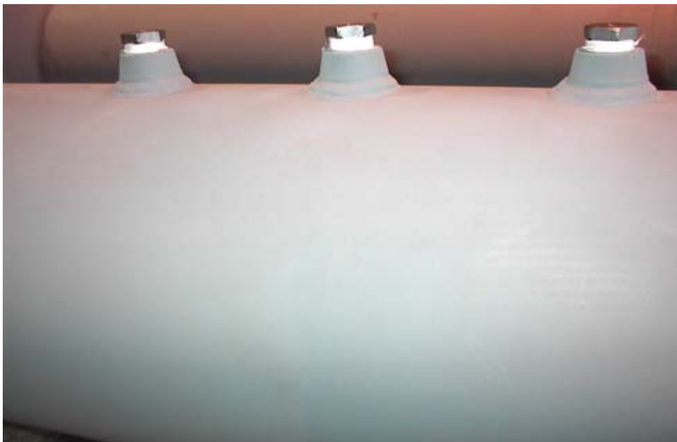
شکل ۳-۵۶: محل نصب پروب‌های چاه حرارتی
